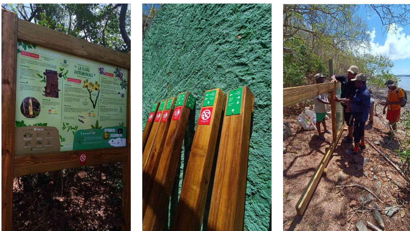
Figure 10 : Panneau pédagogique (gauche), balises directionnelles (milieu) et barrières du Belvédère (droite) lors de leur installation le long du sentier.
